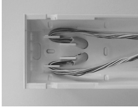
Kabeleinführung von unten
